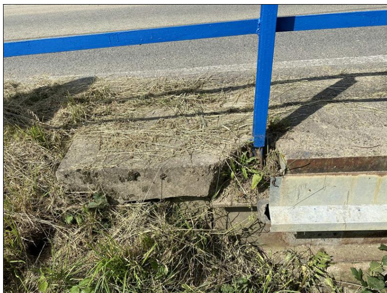
Odpadlá betonová římsa u sloupku zábradlí.
