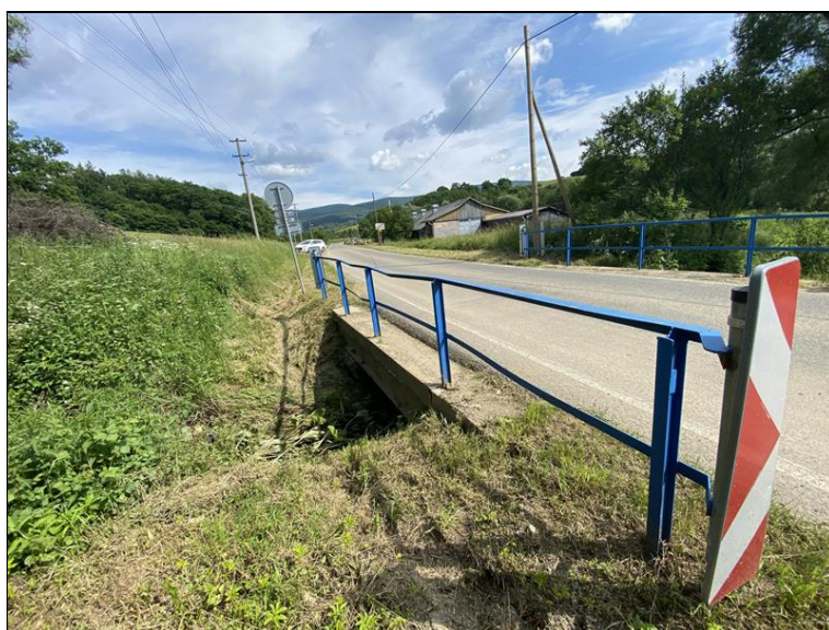
Pohled na zábradlí na návodní straně. Nevhodný typ i ukotvení.
