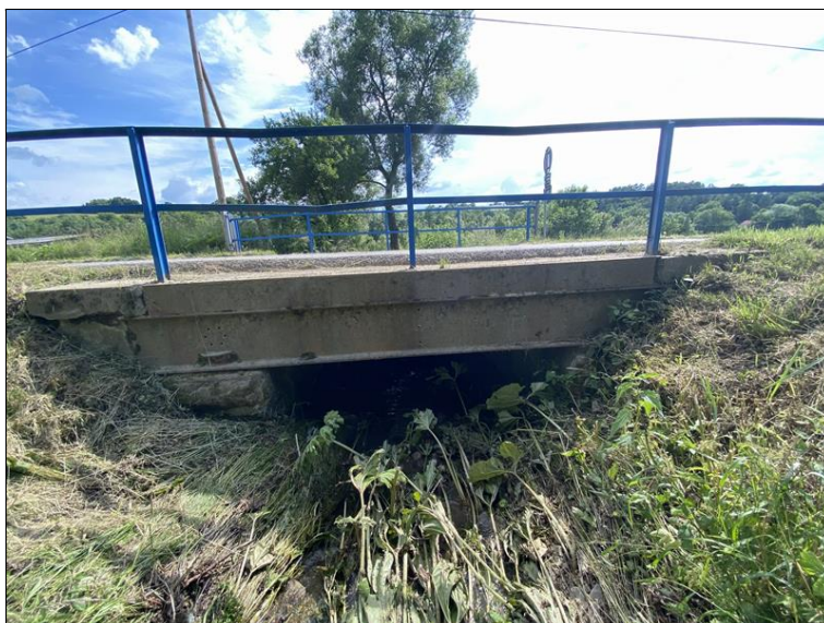
Pohled na velmi malý mostní otvor. Po odečtení rezervy 0,5 prakticky nezůstává plocha na průtok.
