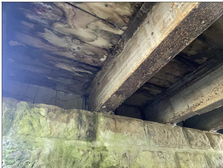
Pohled na spodní líc NK (z návodní strany). Stopy po zatékání na dřevěných mostinách
